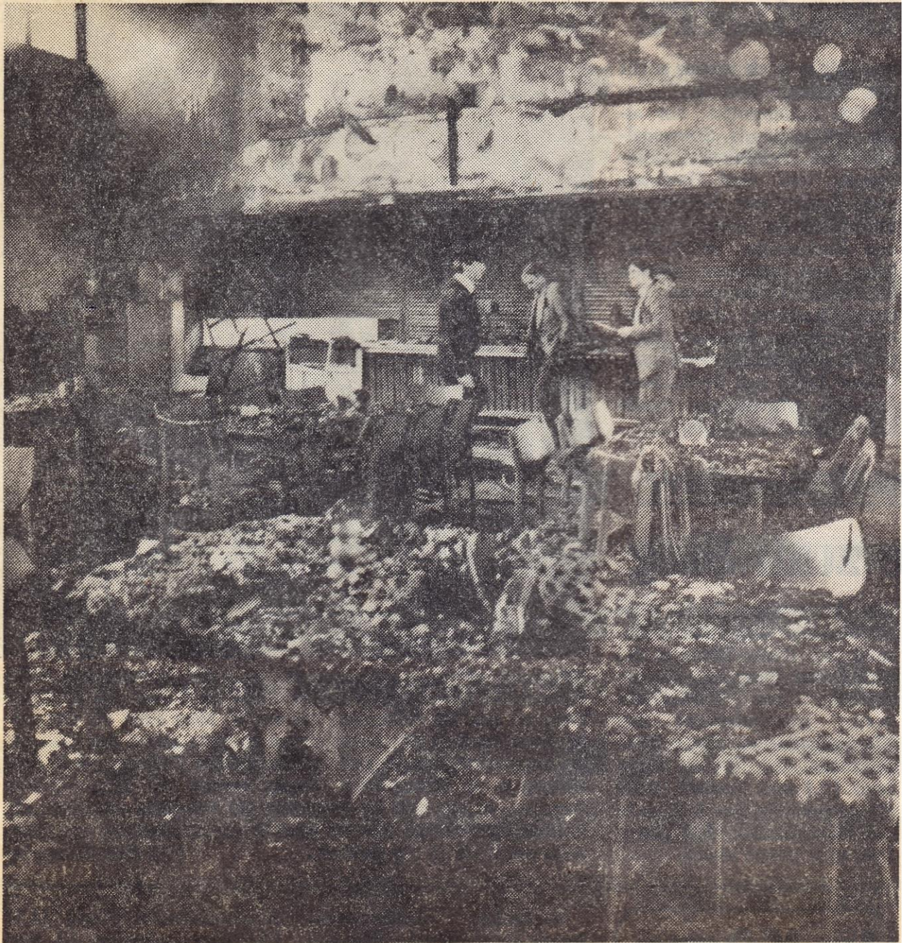
Der Casino-Saal der REME an der Schöntaler Straße brannte vollständig aus. Der entstandene Sachschaden wird auf 600 000 DM geschätzt. Als Brandursache werden ein technischer Defekt oder Fahrlässigkeit angenommen. (WR-Bild: Ingrid Breker)
